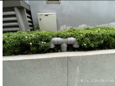
รูปที่ ผ7.12 ท่อระบายก๊าซมีเทน
