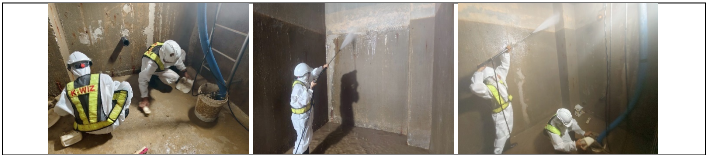
รูปที่ ผ7.18 ล้างถังสำรองน้ำใช้ของโครงการ เมื่อเดือนเมษายน 2568
