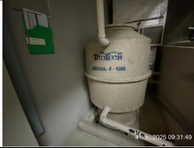
รูปที่ ผ7.11 ระบบกำจัดละอองน้ำเสีย (Aerosol) ของระบบบำบัดน้ำเสีย
