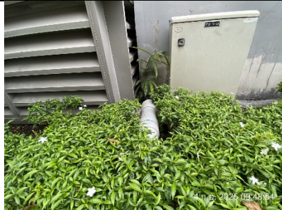
รูปที่ ผ7.12 ท่อระบายก๊าซมีเทน
